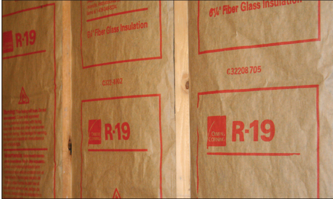
Instalación correcta de fibra de vidrio con barrera de vapor con calificación de Grado 1.
